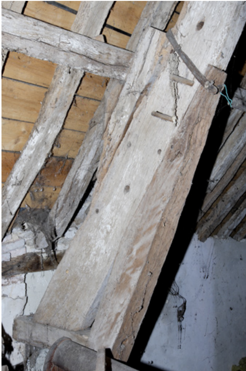
Logis. Charpente. Détail d'un arbalétrier.
