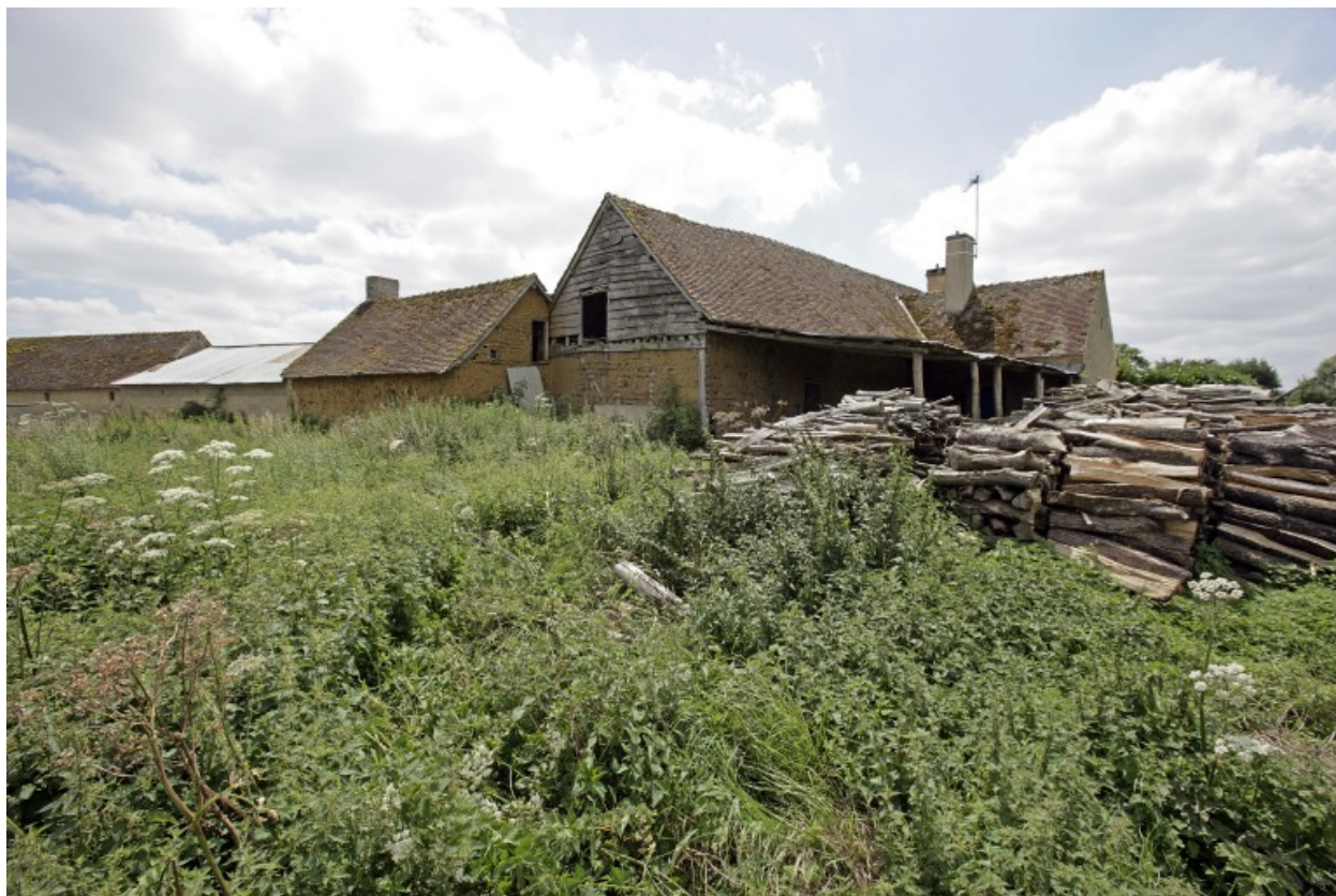
Logis et fournil, élévations postérieures vues depuis le nord.
