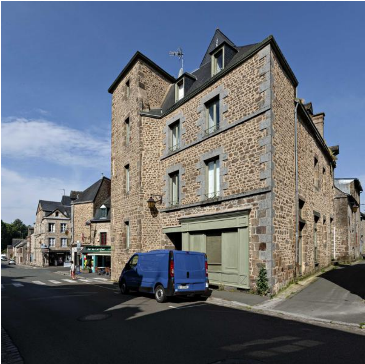
Ancien hôtel particulier, 31-33 rue Dorée. Façade latérale, refaite en 1837 lors du percement de la rue.
