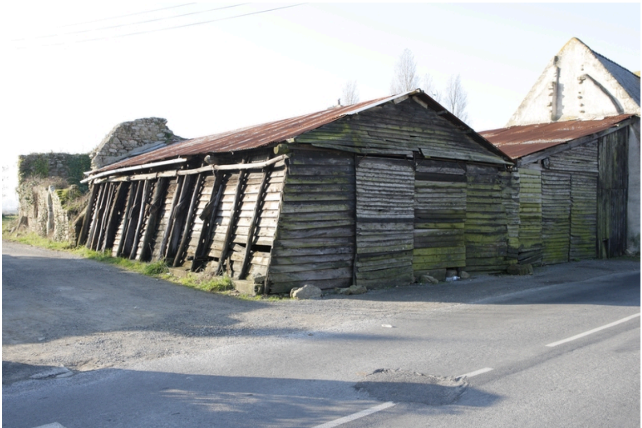
Magasin industriel dit salorge (rue du Ber).
