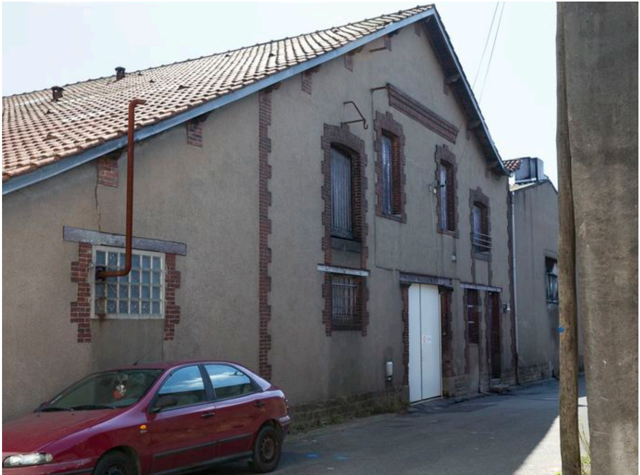
24 rue des Chantiers Crucy : stockage et fabrication vinaigre de vin et de cidre (abrite le premier fermenteur acheté par l'entreprise).
