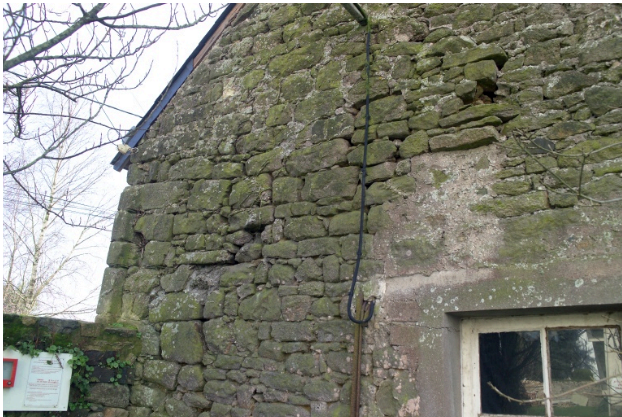
Bâtiment est. Détail de la reprise de construction sur le pignon du bâtiment nord.
