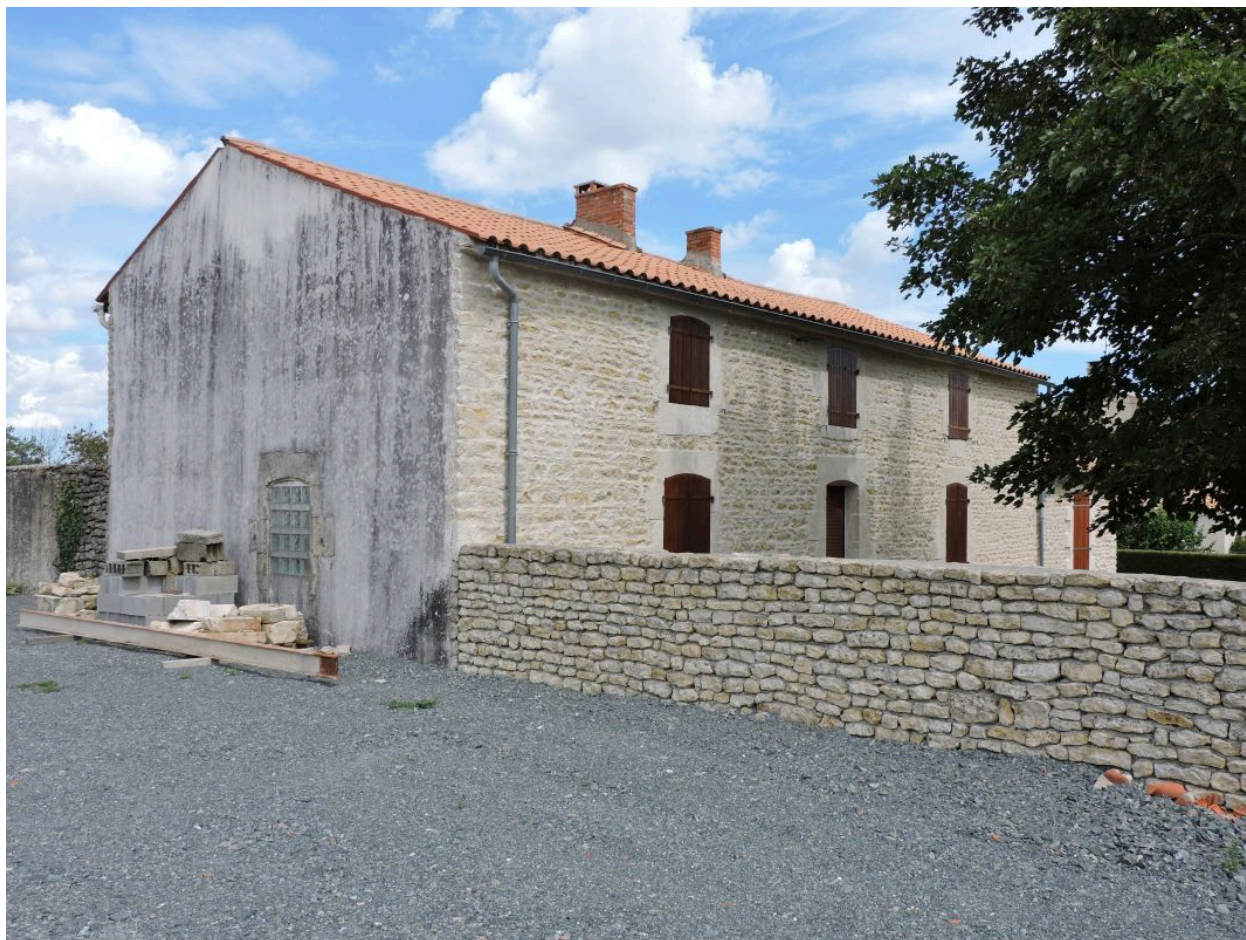
Le logis vu depuis le sud.
