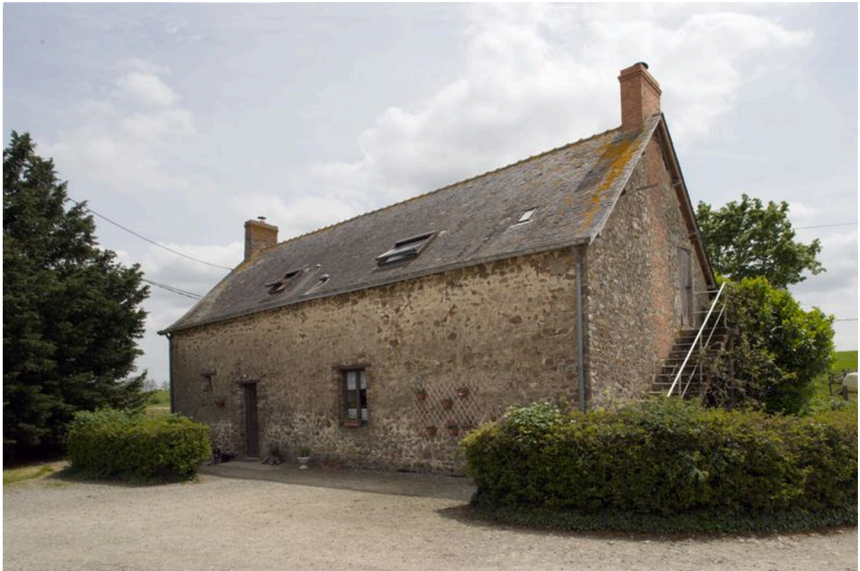
Le logis actuel vu depuis la cour au nord-ouest.
