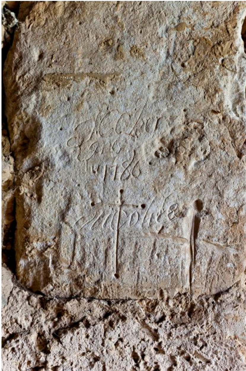
Ferme 1, maison, mur extérieur nord : détail des inscriptions à gauche de la baie.
