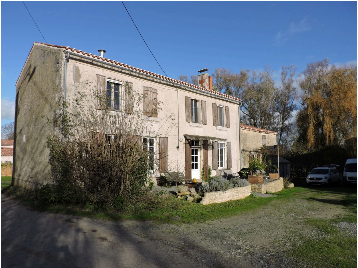
Le logis et le logement dans son prolongement, à droite, vus depuis le sud-ouest.
