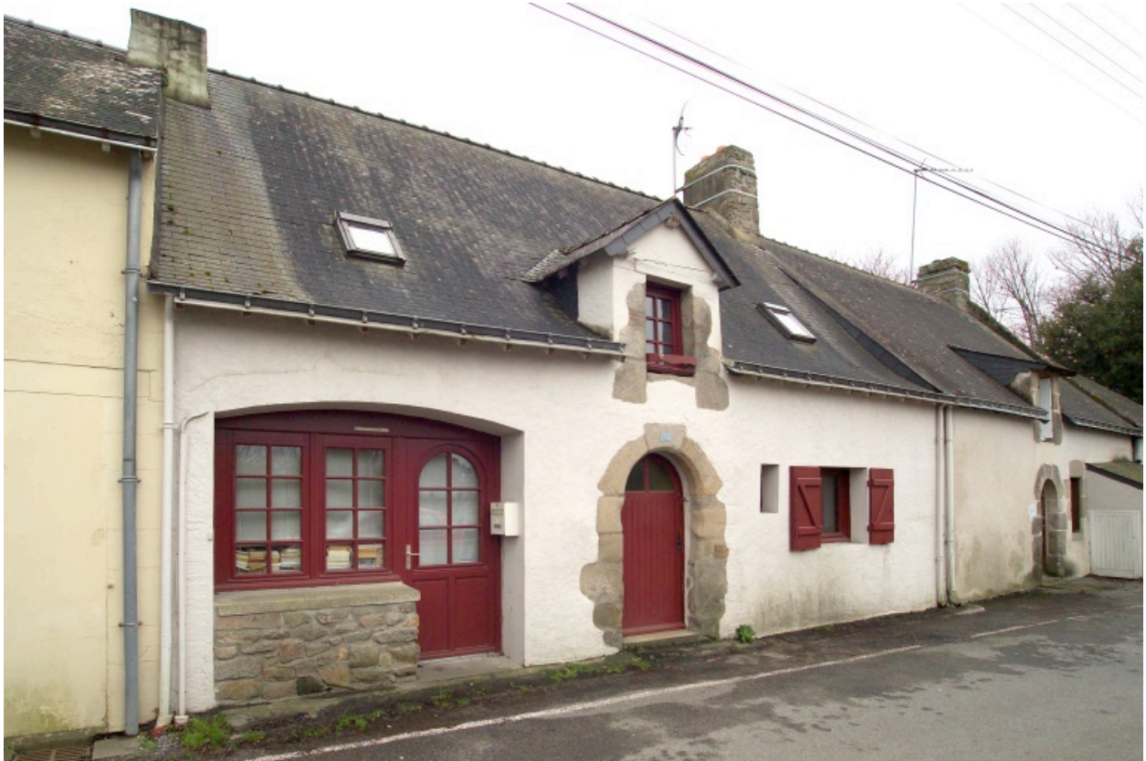
Vue de la façade sur rue.
