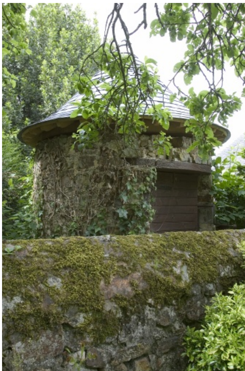
Le puits vu depuis la cour au sud.
