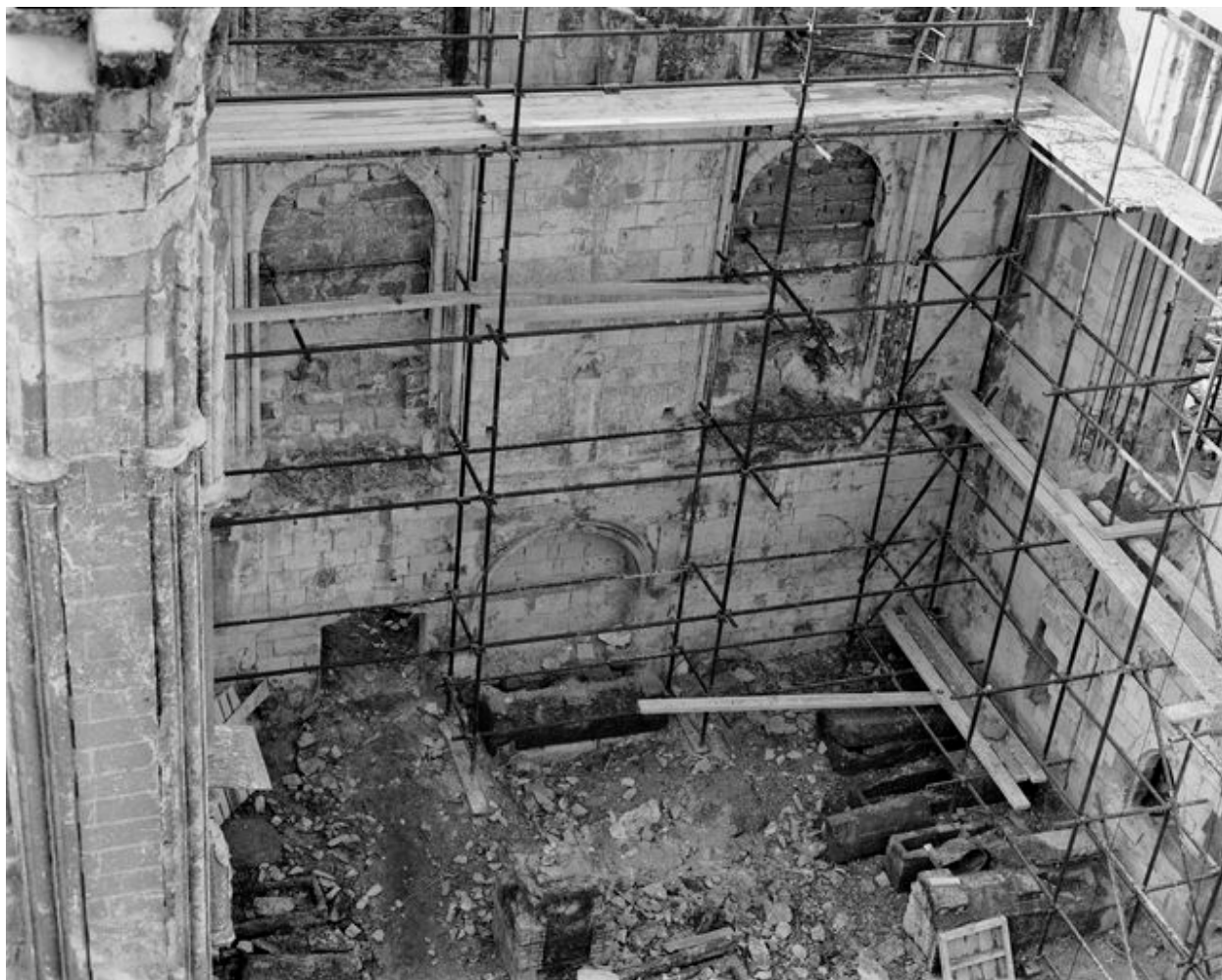
Abbatiale, bras sud du transept : élévations sud et ouest.
