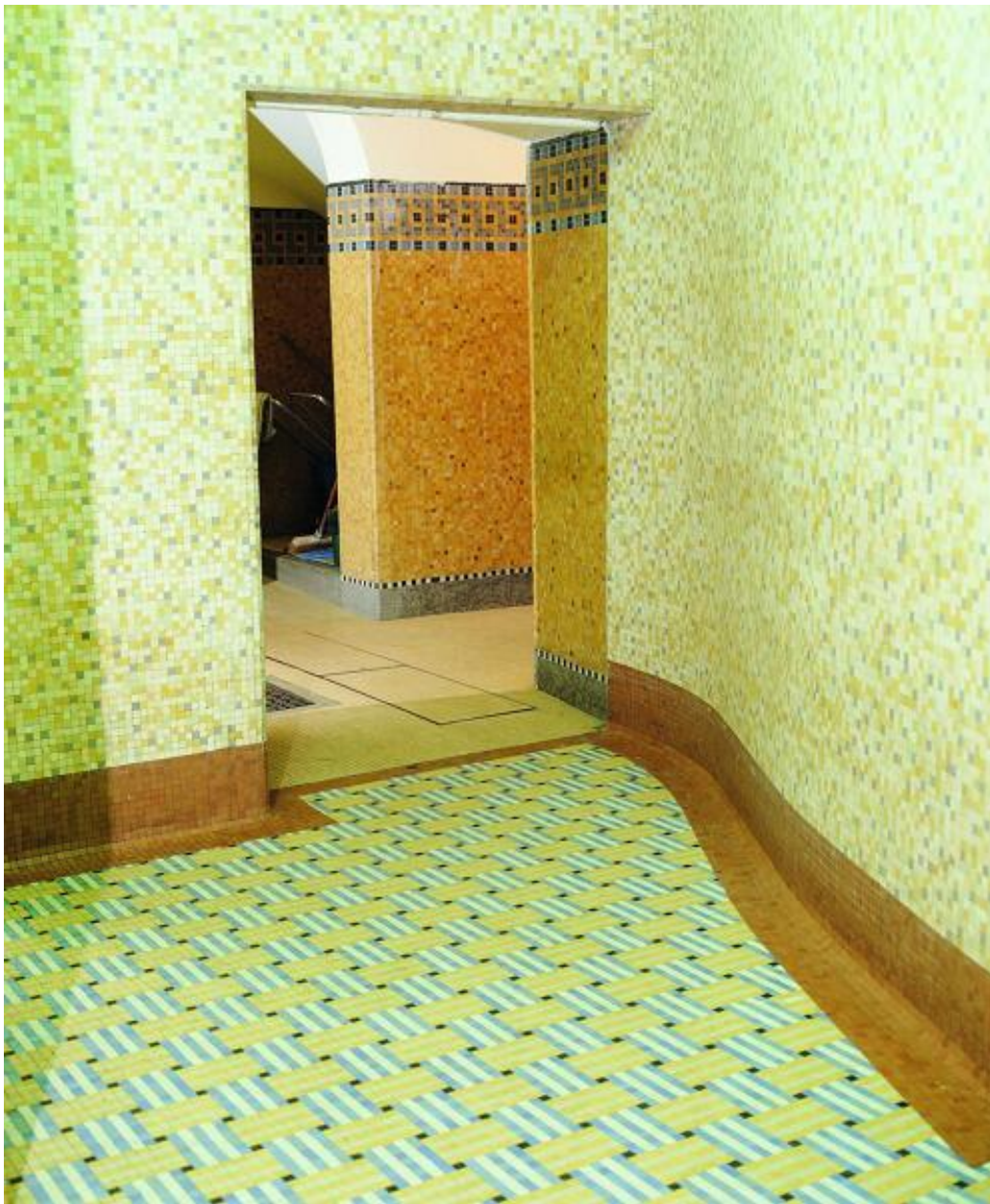
Bâtiments conventuels : liaison intérieure entre l'aile de la cuisine et l'aile du réfectoire (nord), rez-de-chaussée : détail des revêtements mosaïqués.
