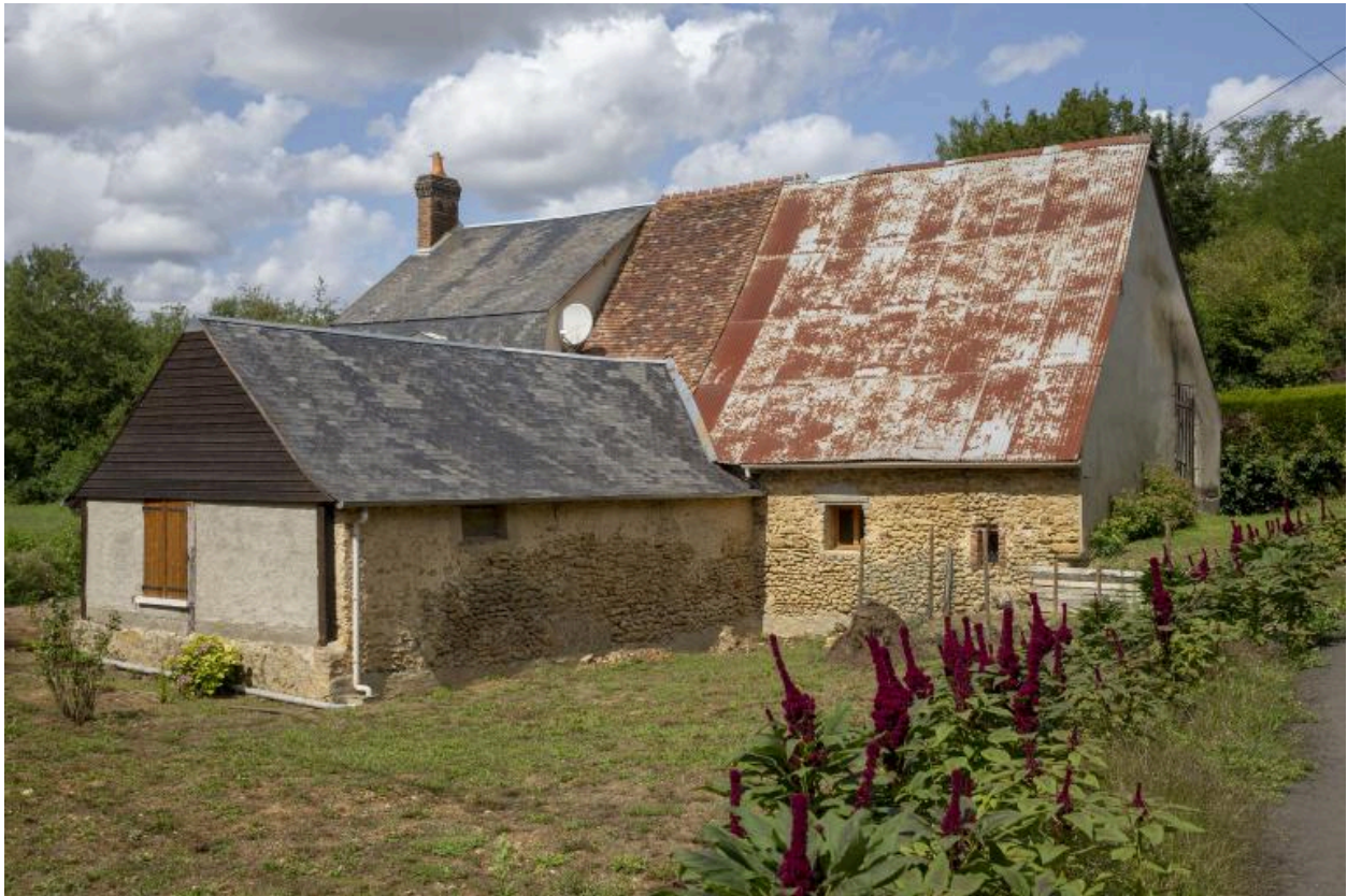
Les bâtiments du moulin, côté route.
