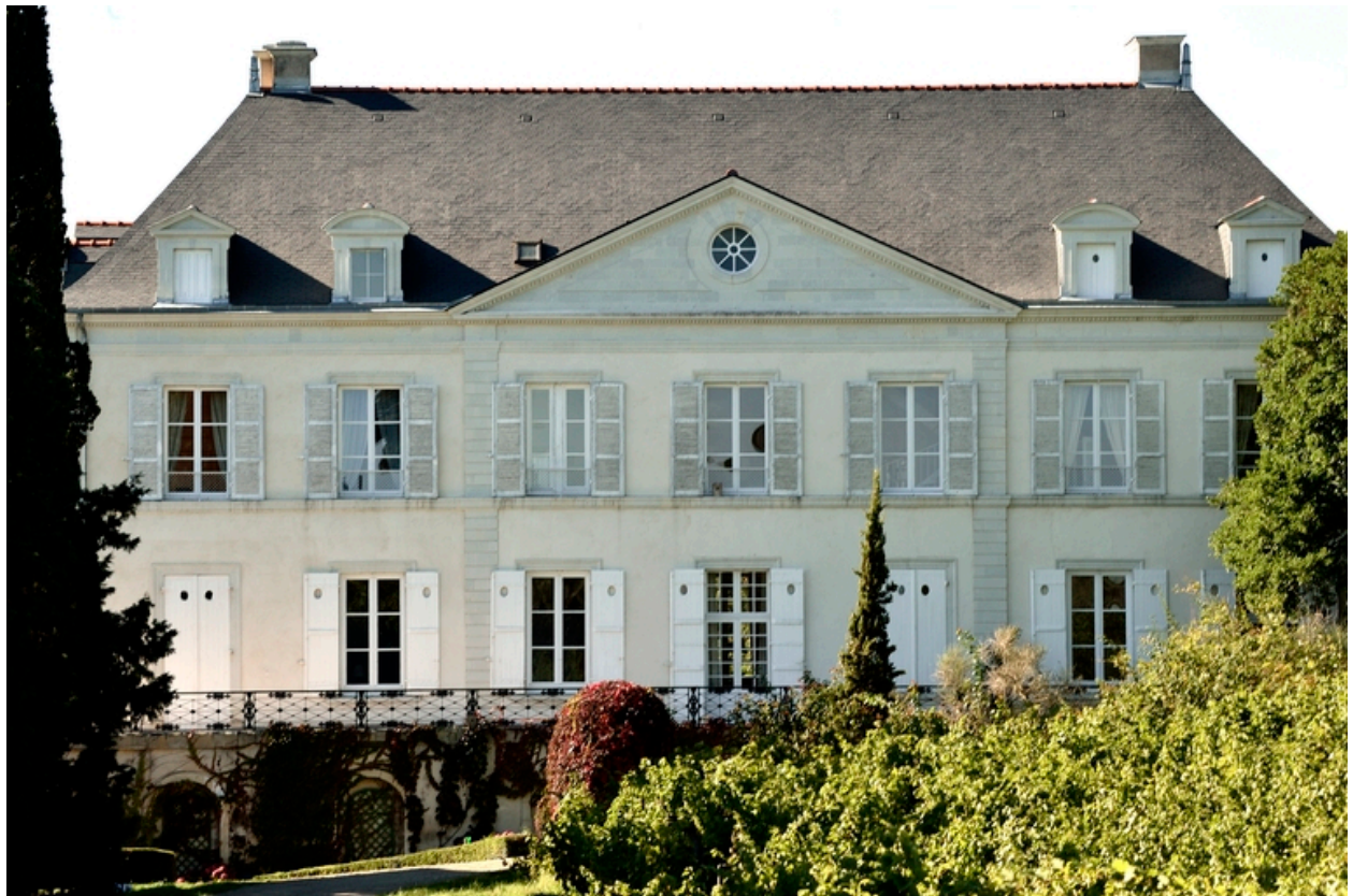
Vue de la façade arrière.
