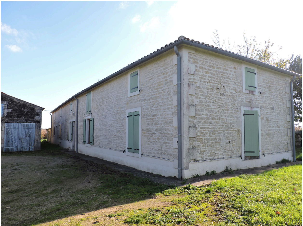
Le logis vu depuis le nord-ouest.
