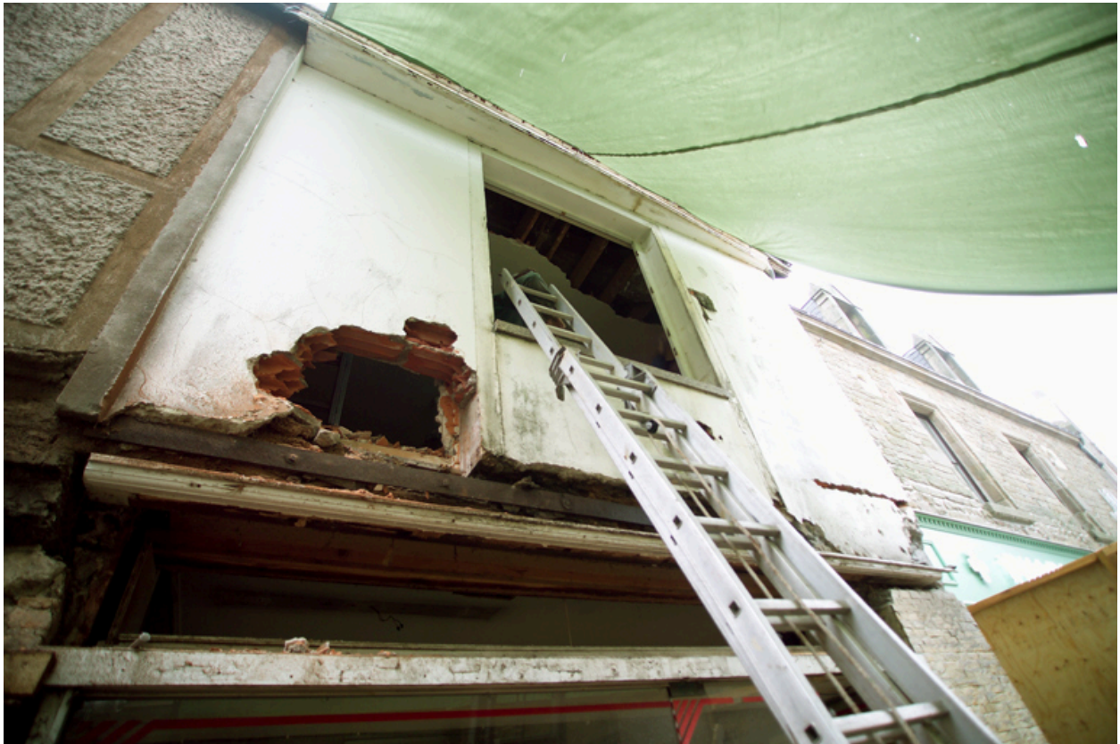
Détail de la moitié occidentale de la façade nord, avant travaux.
