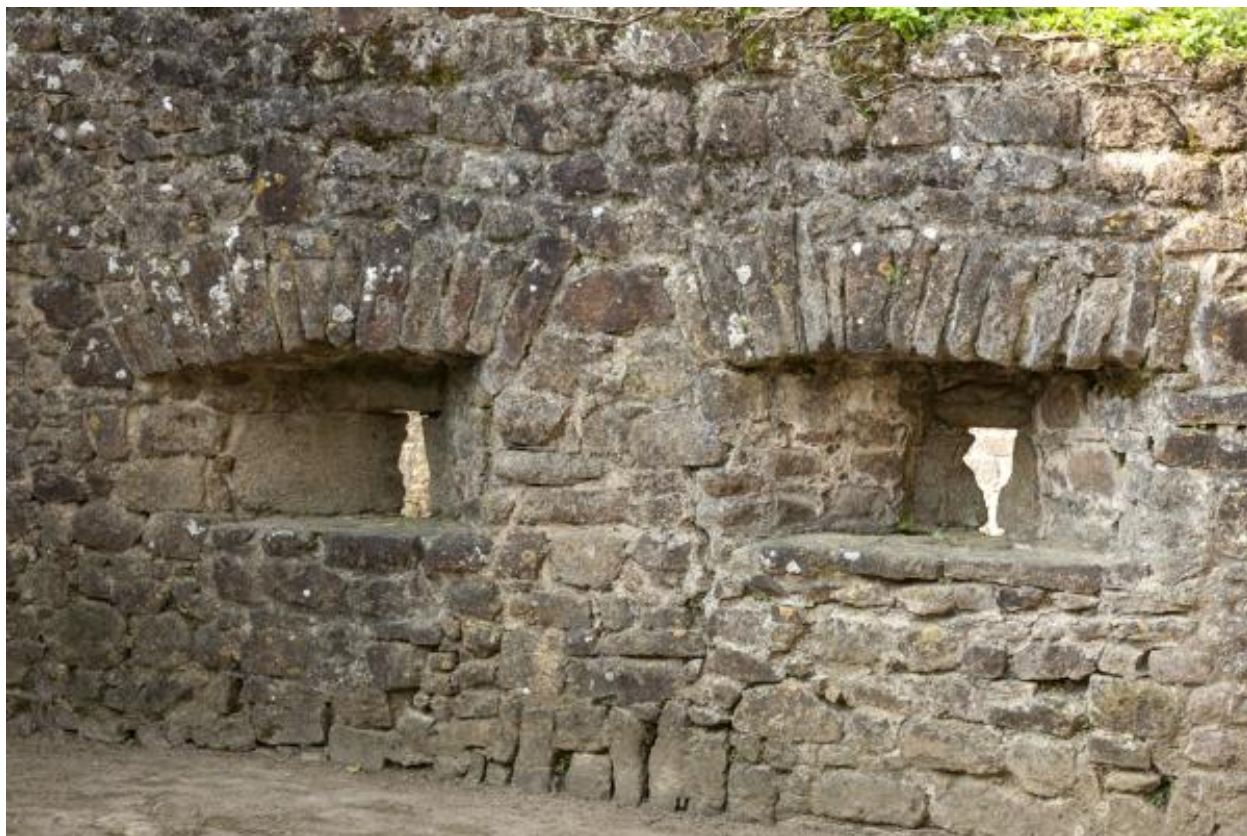
Mur fermant la gorge du boulevard.
