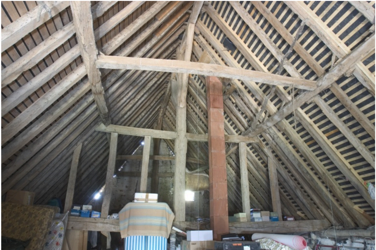
La charpente du logis : fermes ouest.
