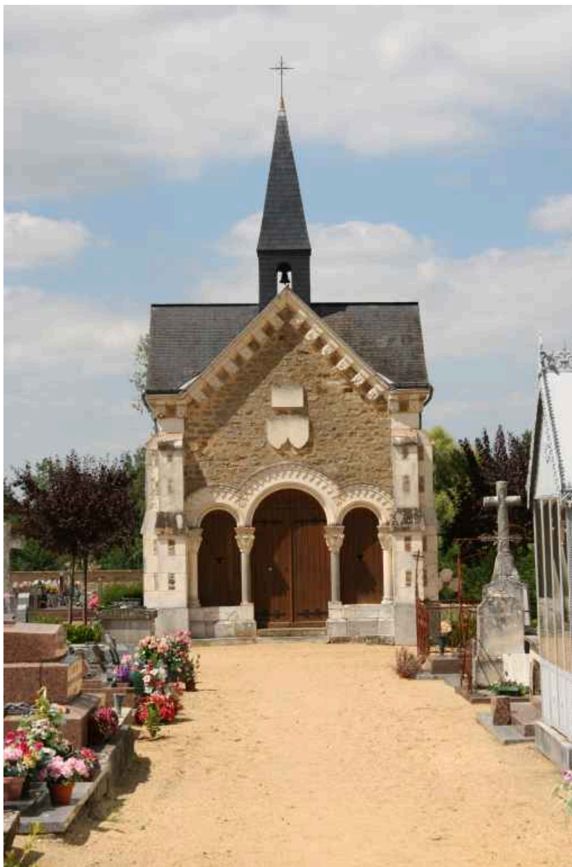
Vue d'ensemble : façade antérieure.
