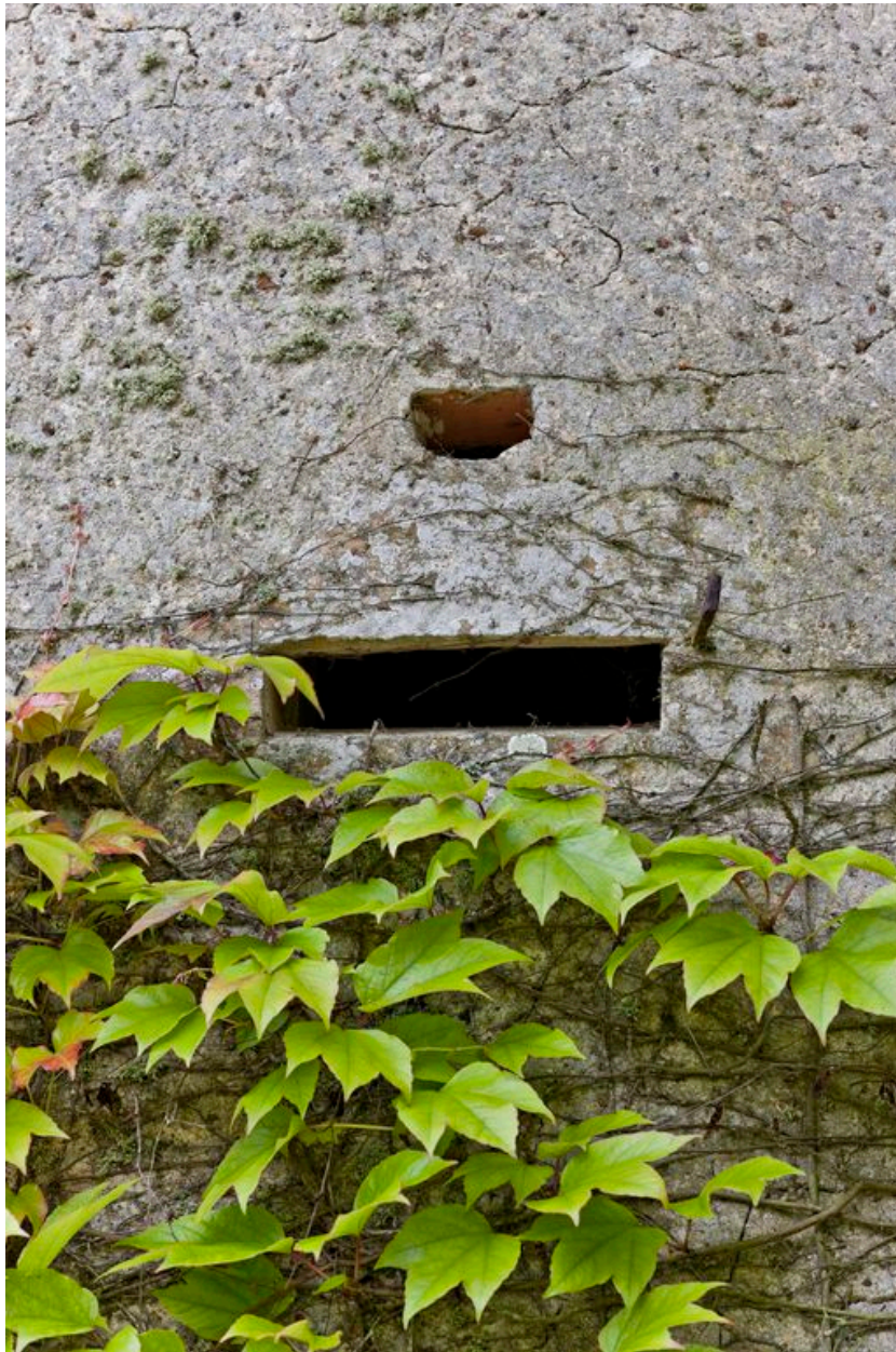
Meutrière de fusillade à l'étage de la tour d'escalier, limite des XVIe et XVIIe siècles.
