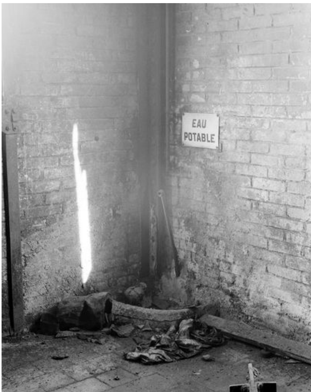
Nouvelle usine. Atelier des appareils à cuire. Distributeur d'eau potable.
