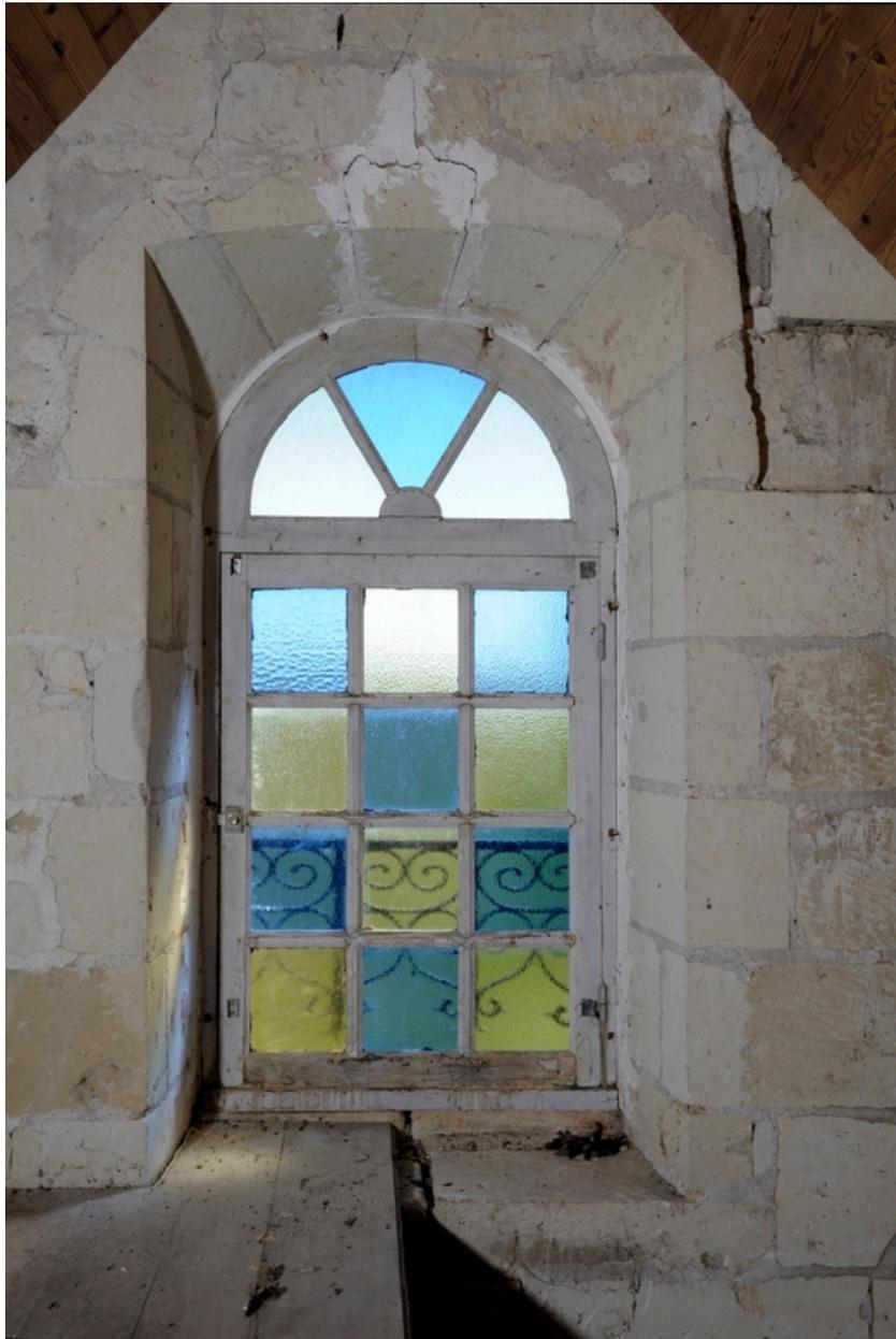
Corps ouest, intérieur, comble : baie dans le pignon nord, couverte d'une arrière-voussure de Marseille.
