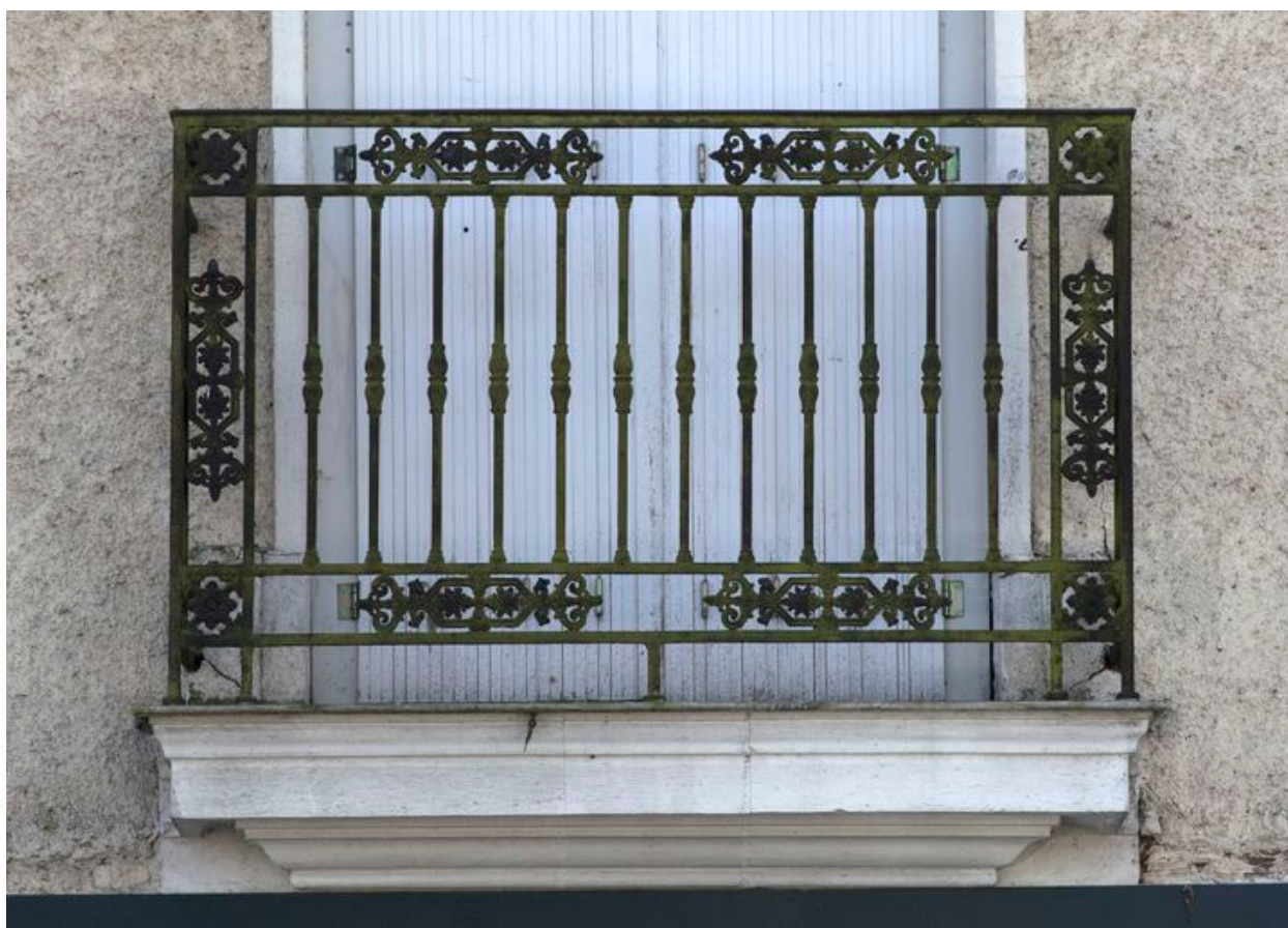
Détail de ferronnerie, 31 rue Bougainville.
