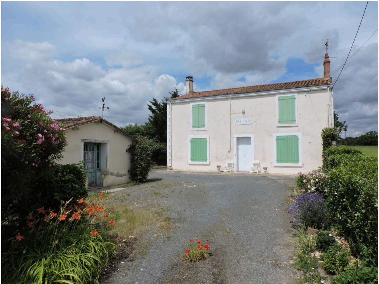
Le logis et le fournil-buanderie vus depuis l'est.
