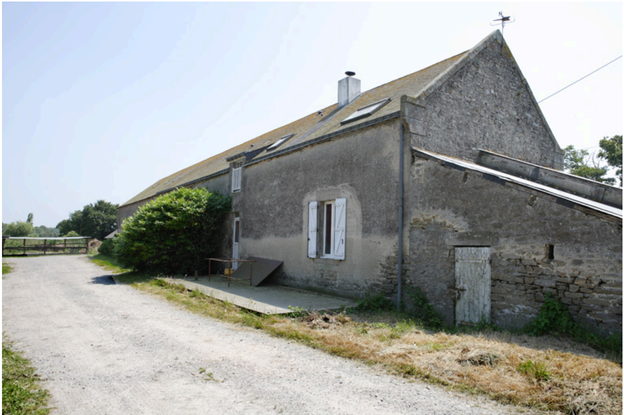
Vue de la façade nord depuis le nord-ouest.
