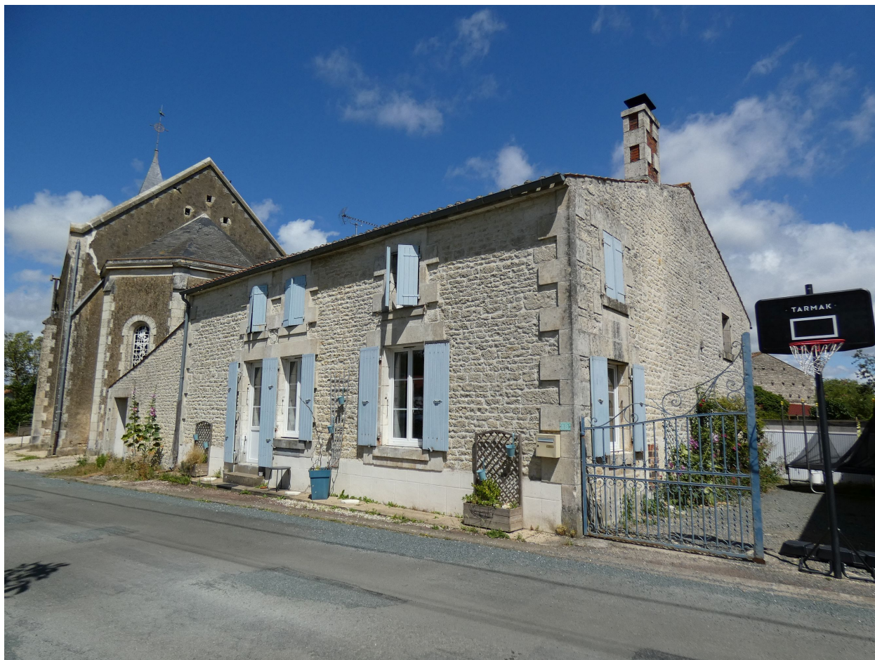
L'ancienne ferme vue depuis l'ouest.
