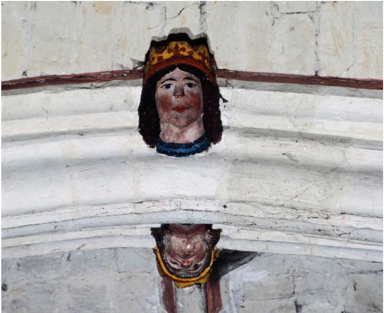
Première travée de la nef. Clef du doubleau (ici, côté première travée), sculptée en bas-relief d'une tête de roi (vue prise en 1991).
