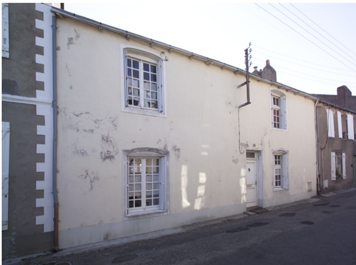
La maison n° 5 bis rue de Bel-Air.
