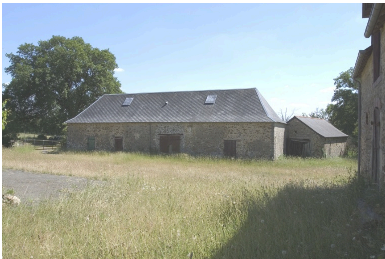
L'étable. A droite, la remise
