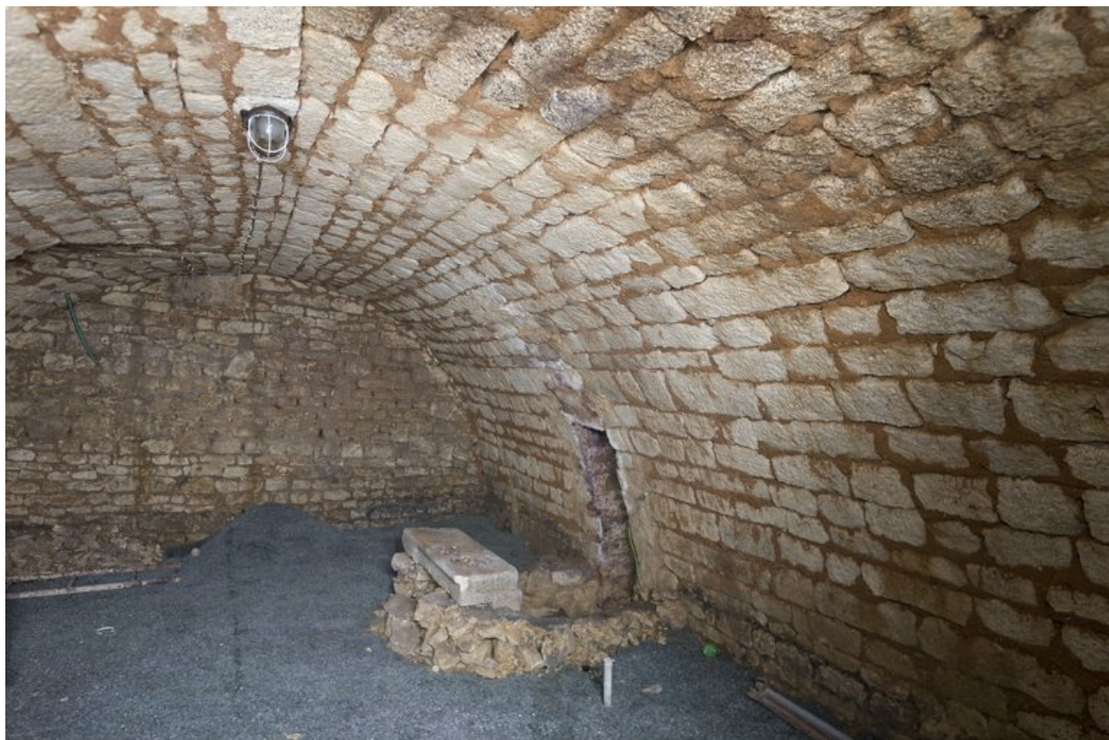
Vue du sous-sol, prise de l'ouest. Noter le puits, à droite.
