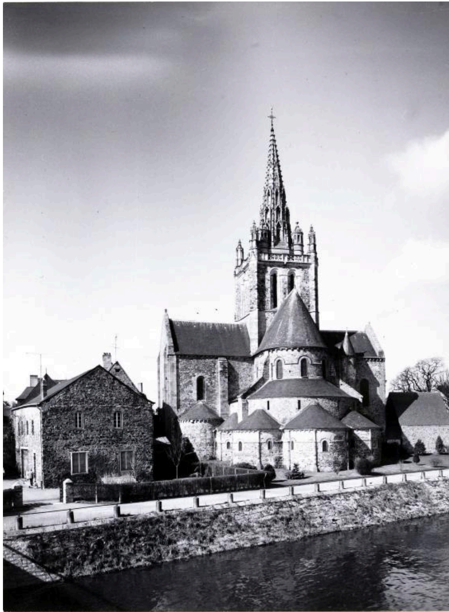
Eglise, vue d'ensemble depuis le sud-ouest.
