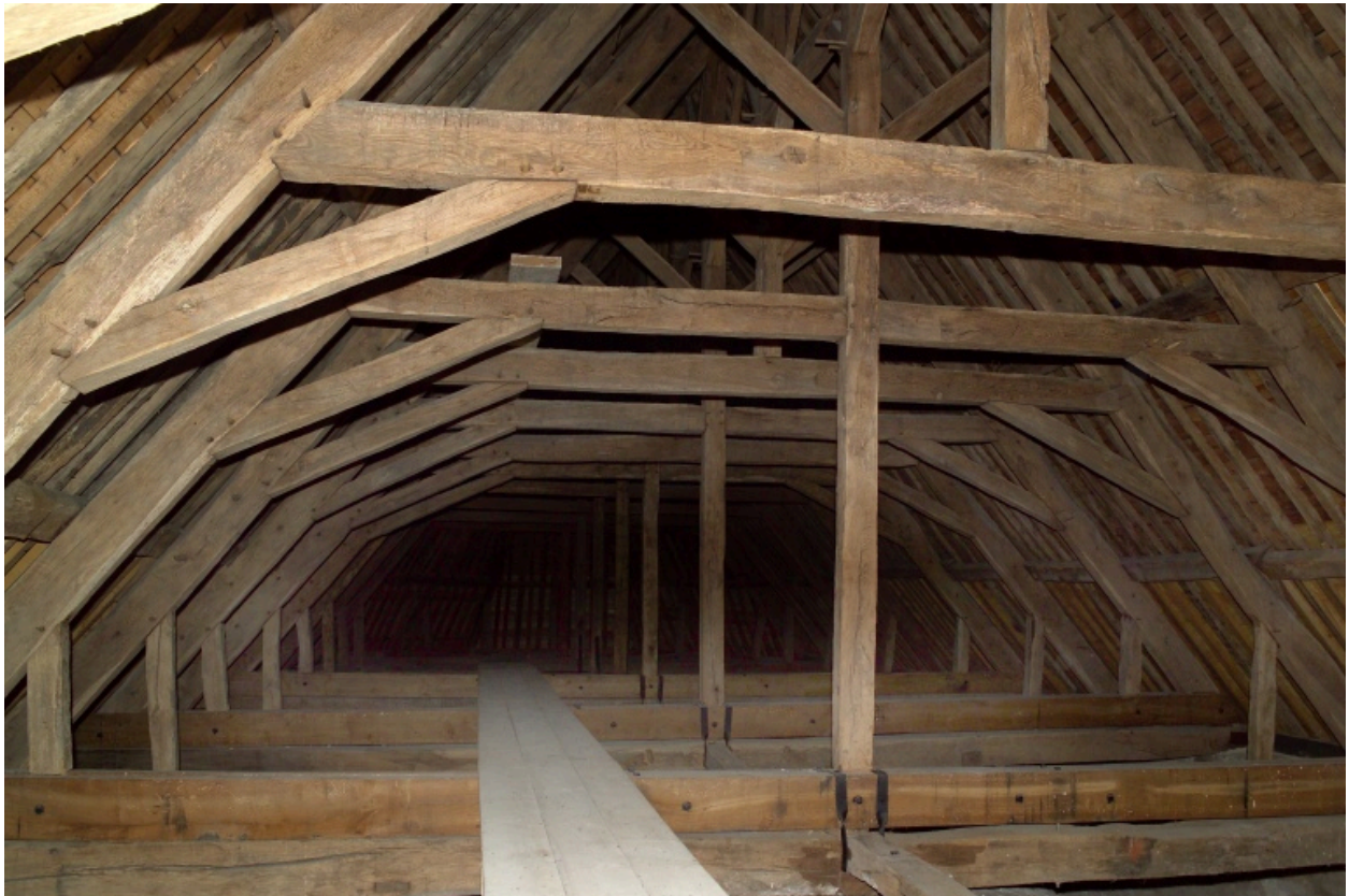
Charpente vue depuis l'ouest.
