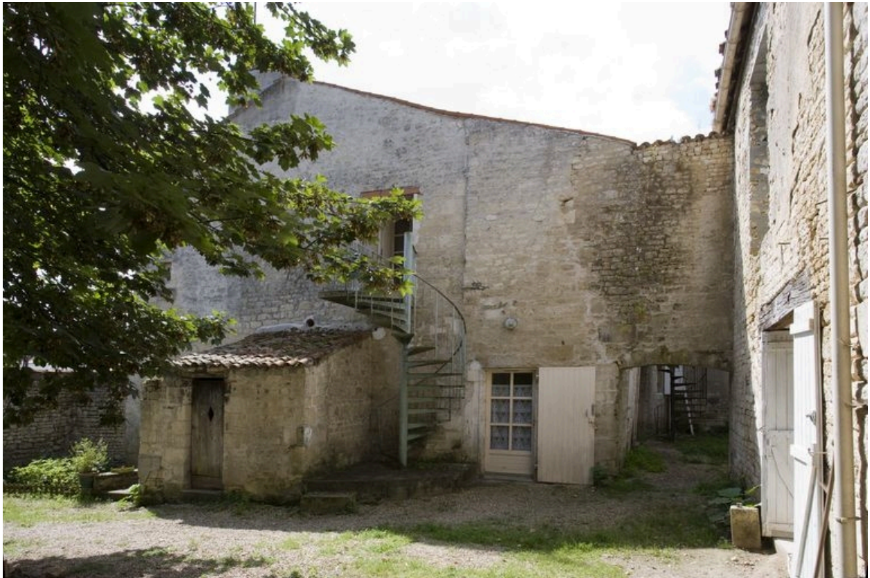
Vue prise du nord, montrant la façade nord de la maison et le passage entre les deux cours.
