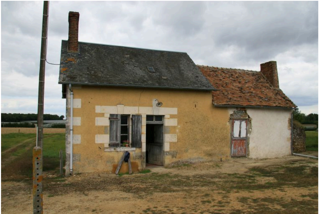
Le petit logement : la façade antérieure.
