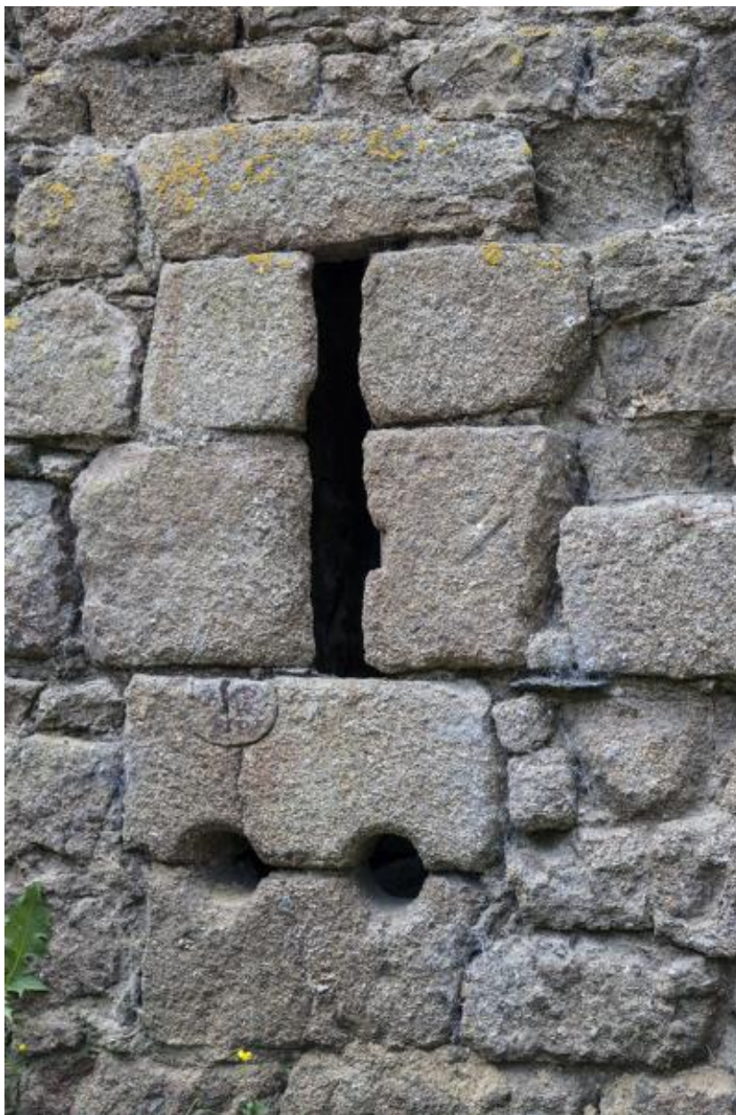
Bouche à feu du flanc oriental du boulevard d'artillerie.
