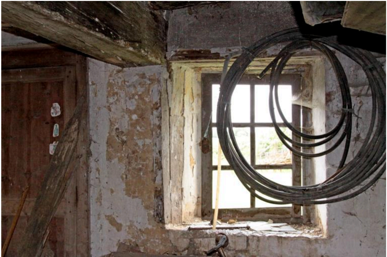
Maison : petite fenêtre à côté de la grosse poutre.
