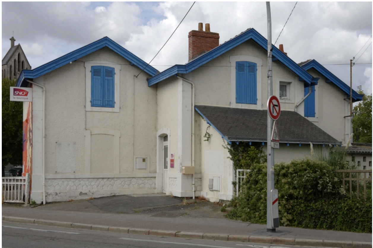
Arrière de la gare de Doulon.
