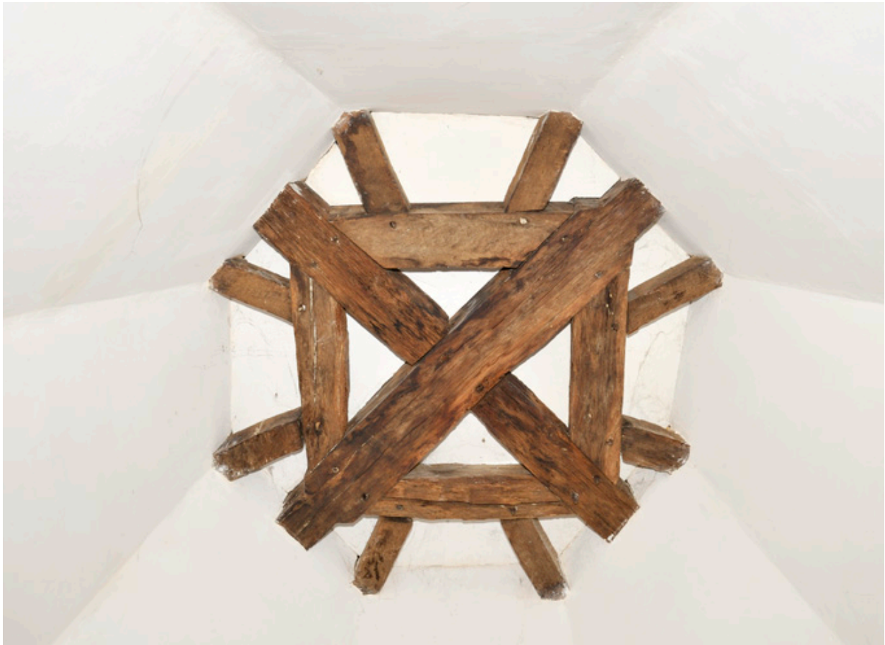
Tourelle d'escalier : enrayure haute de la charpente.
