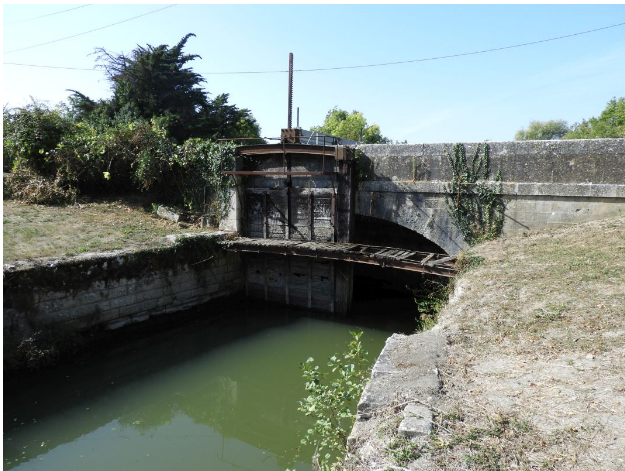
L'aqueduc vu côté amont, depuis le nord-est, avec la vanne remplacée en 2020.
