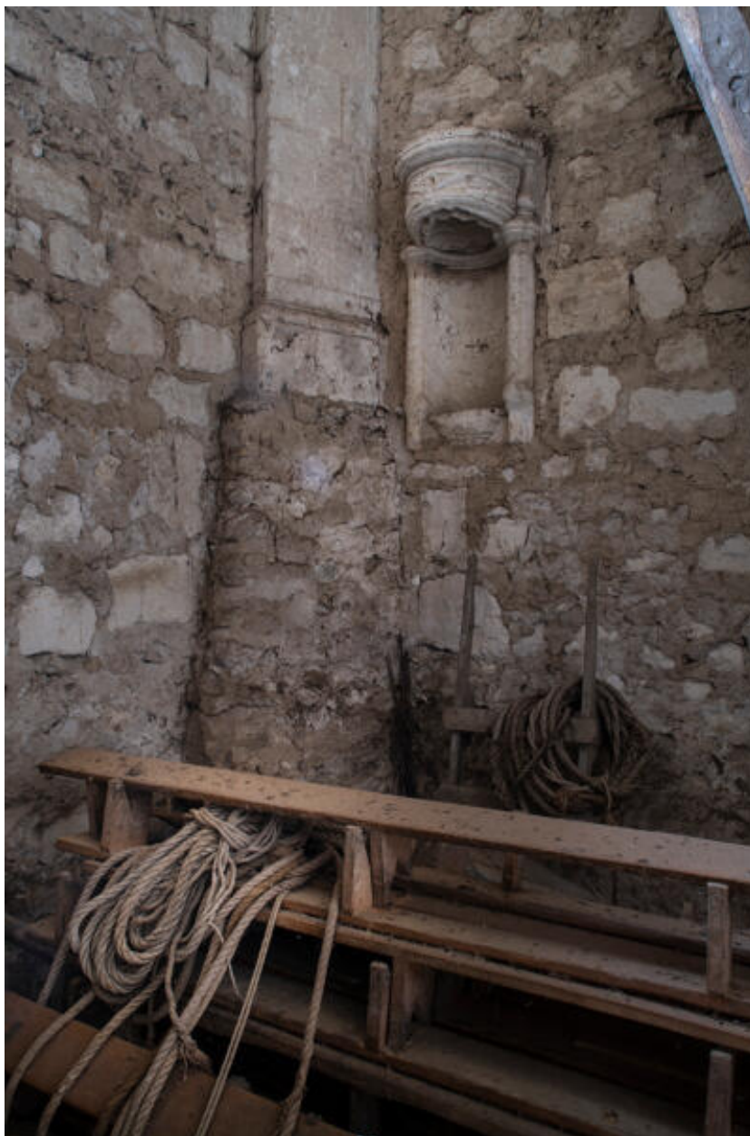
Rez-de-chaussée de la tour-clocher : contrefort de l'abside du choeur et niche de remploi.
