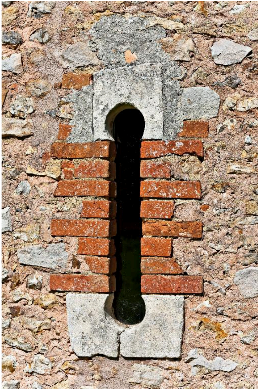
Jour dans l'élévation postérieure du logis.
