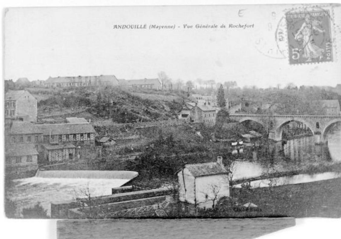
Vue d' ensemble du site depuis la rive gauche : usine néo-métallurgique, barrage, pertuis, canal d'accès à l'écluse, écluse, maison éclusière. A l'arrière-plan, le pont de Rochefort et en hauteur, la cité ouvrière.
