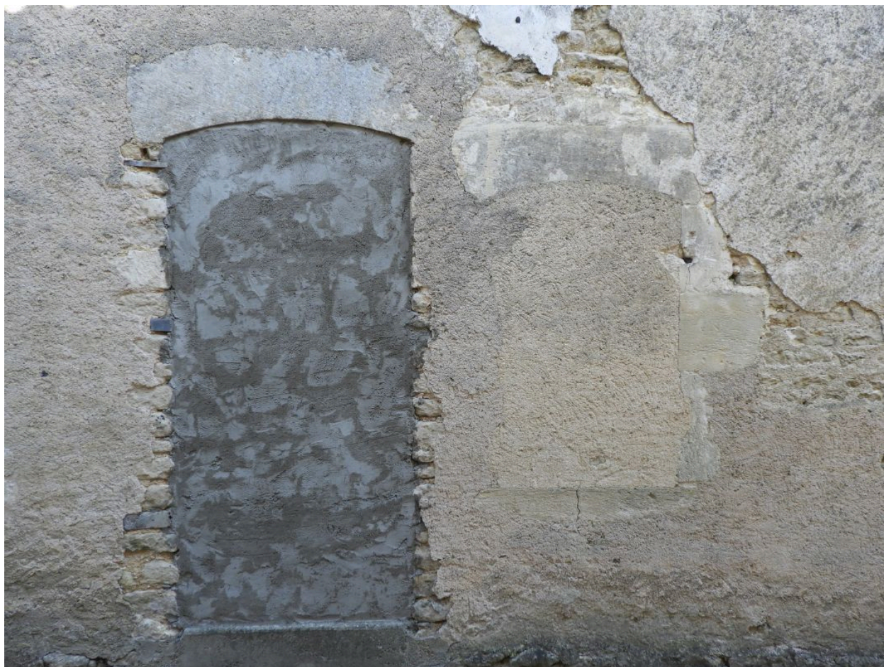
Vestiges de baies à linteau en arc segmentaire sur le mur pignon de l'ancienne auberge, rue du Lion d'Or.
