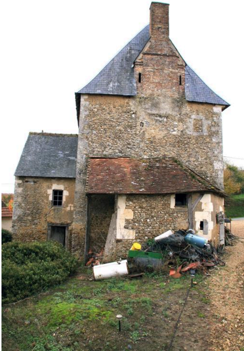
Pavillon, face ouest avec cheminée et appentis.
