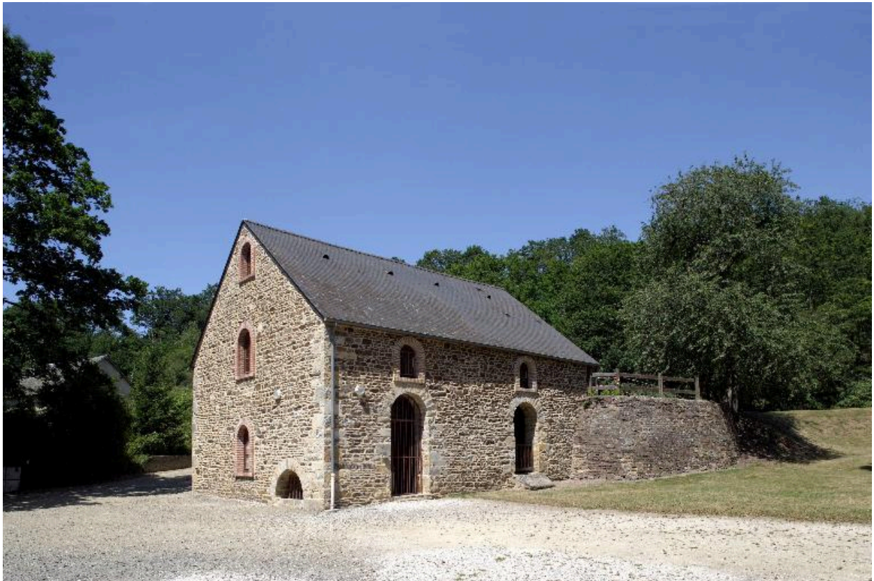
Le moulin vu depuis le sud.
