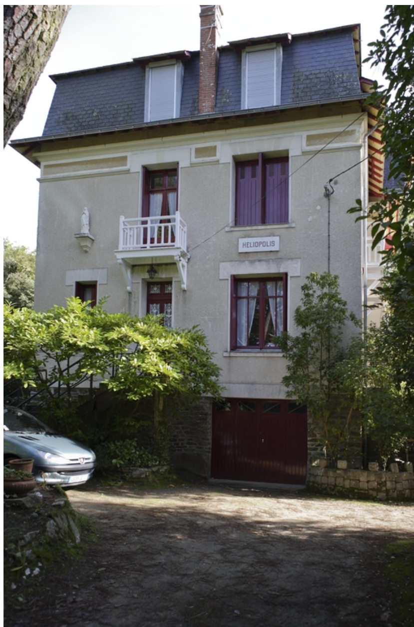
Façade antérieure sur rue.
