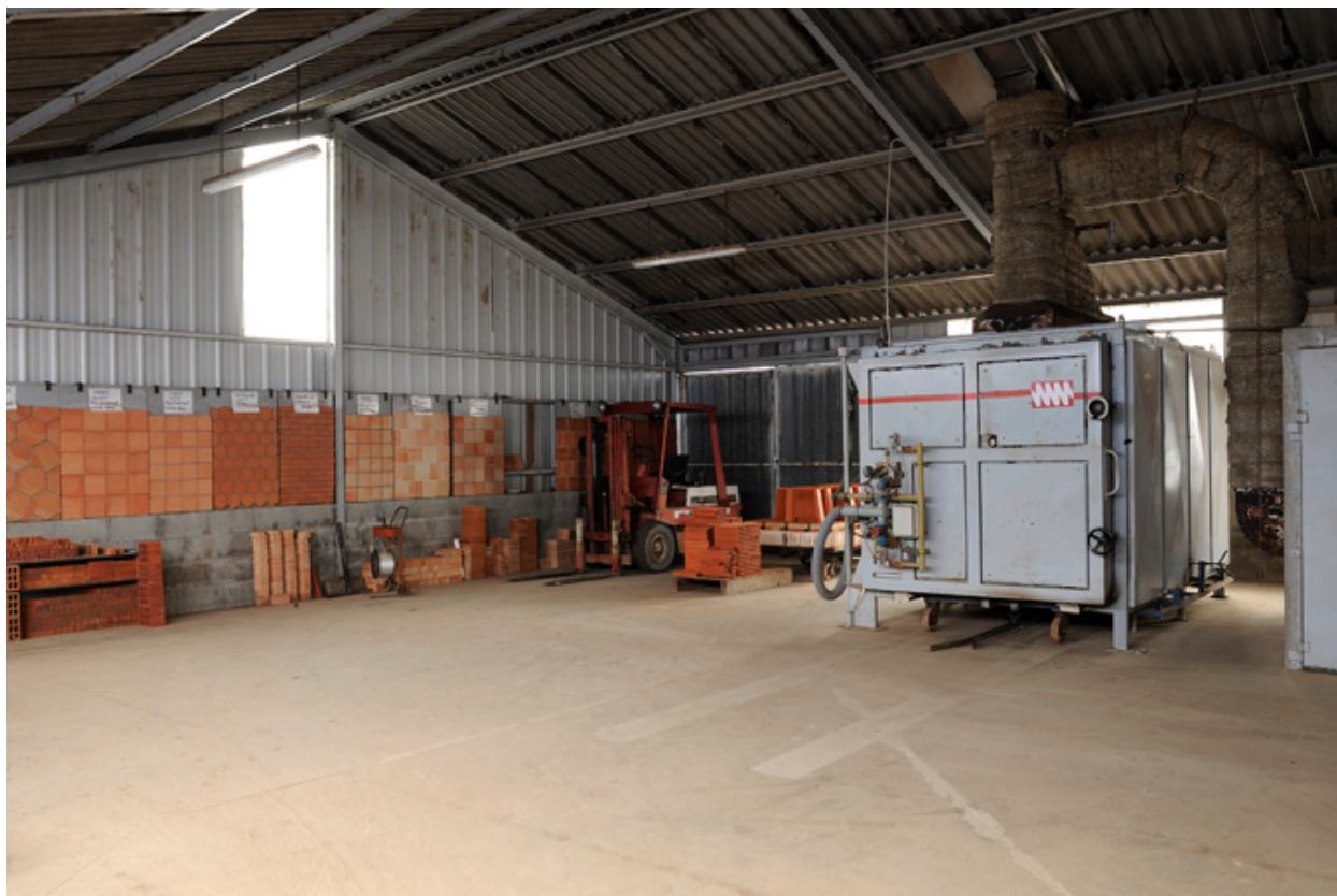
Pièce de stockage et four à gaz.
