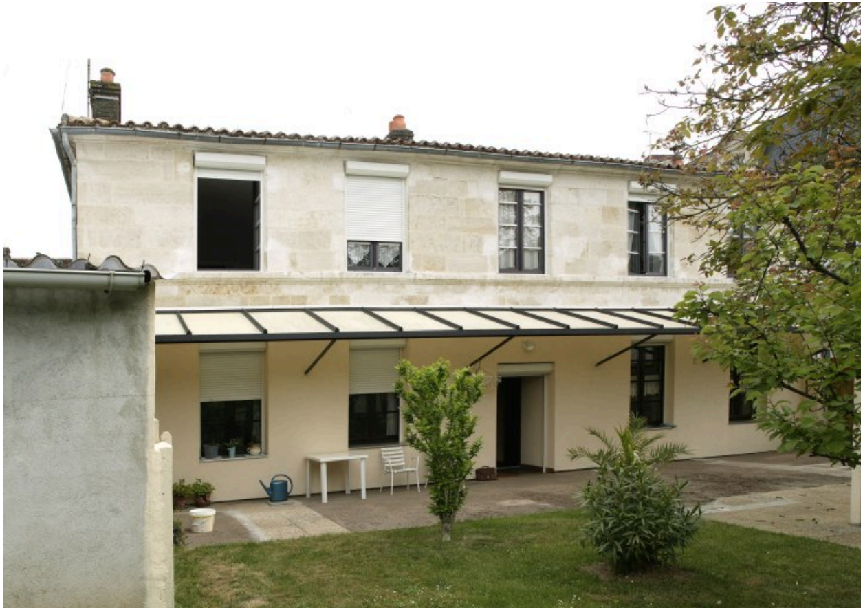
Façade principale, donnant sur le jardin.
